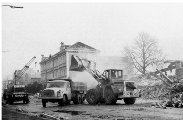
1987 • demolice školní jídelny, stavba nového mostu
